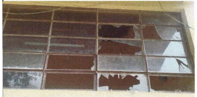
Foto 2: Sustitución de vidrios
