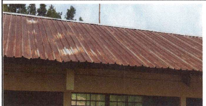
Foto 5: CANALES Y BAJADAS DE AGUA PLUVIAL
