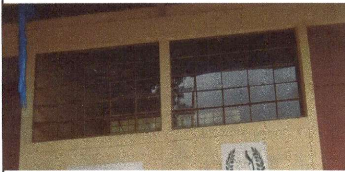
Foto 3: balcones de metal
